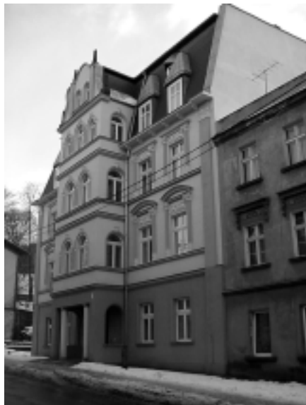
Odremontowany po pożarze budynek przy ulicy Przechodniej jest jednym z ładniejszych w Nowej Rudzie. fot. W. Grzybowski
